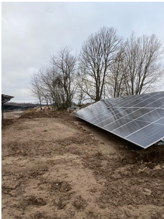
Figur 6. Exempel på monterande solpaneler i ett så kallat bord.
