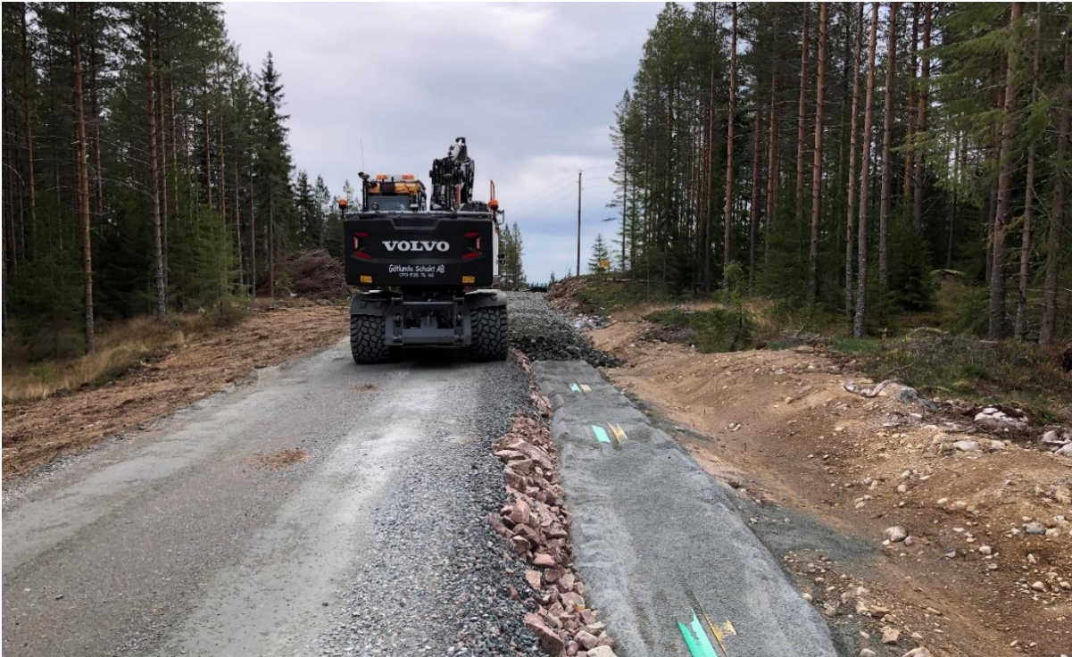
Figur 17 Kabelgrav för elledningar och kommunikationsnät intill väg. Foto: SR Energy AB.
