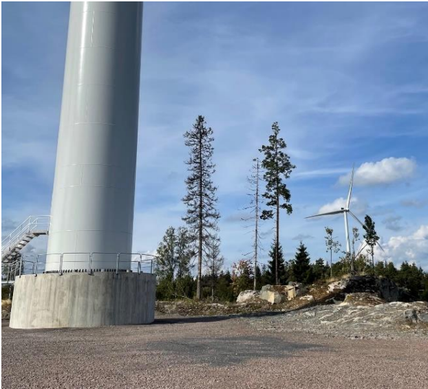
Figur 25 Foto över ett vindkraftverks fundament.
