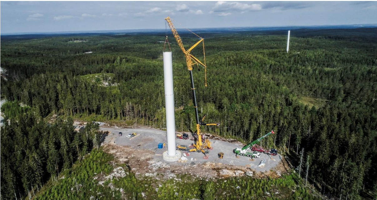
Figur 26 Montering av vindkraftverk. Foto: SR Energy AB.
