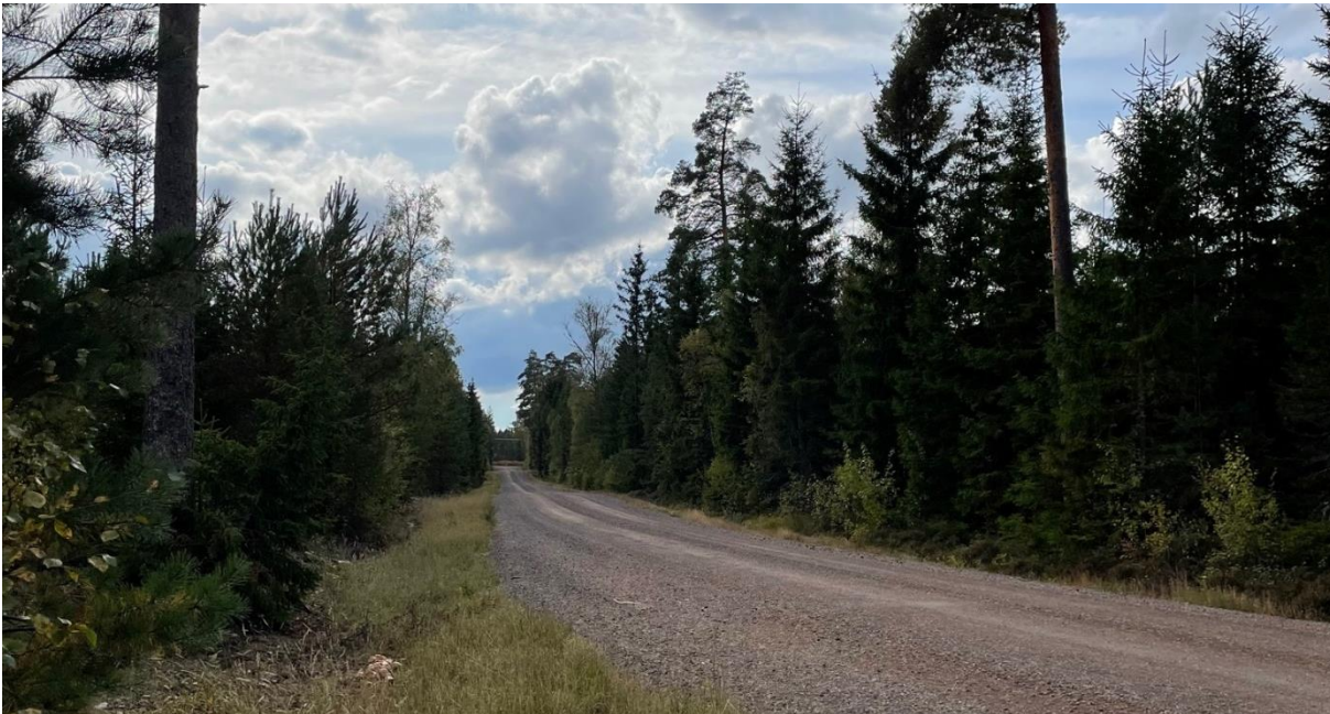
Figur 14 Upprustad befintlig väg som använts för transport av vindkraftverk vid SR Energys vindpark Tvinnesheda. Eftersom vägen är rak och plan har behovet av avverkning invid vägen varit minimal.
