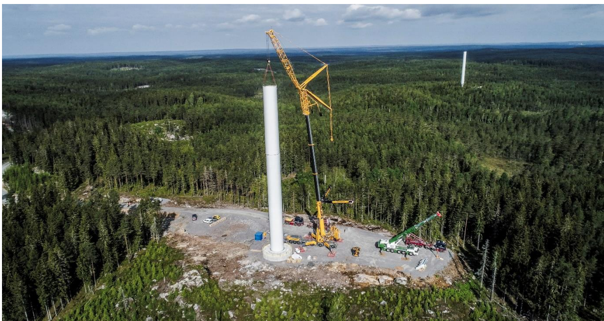
Figur 7. Montering av vindkraftverk. Foto: Stena Renewable AB
