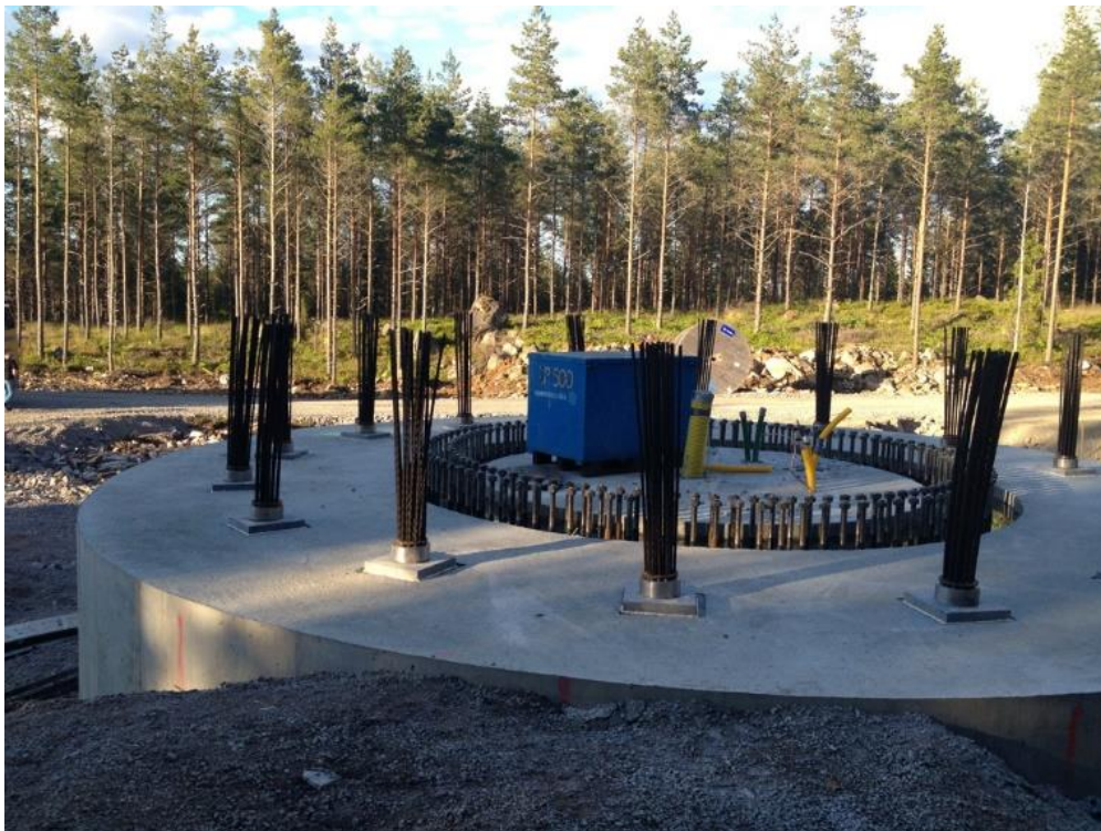
Figur 12. Bergförankrat fundament i Stena Renewables vindpark Lemnhult. Källa: Stena Renewable
