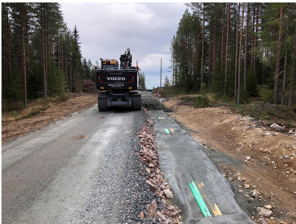
Figur 19. Kabelgrav med kabel och kommunikationsnät intill väg. Foto: Stena Renewable AB
