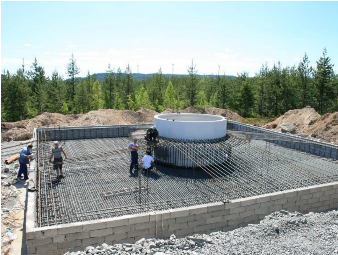
Figur 11. Gravitationsfundament i en av Stena Renewables vindparker. Källa: Stena Renewable
