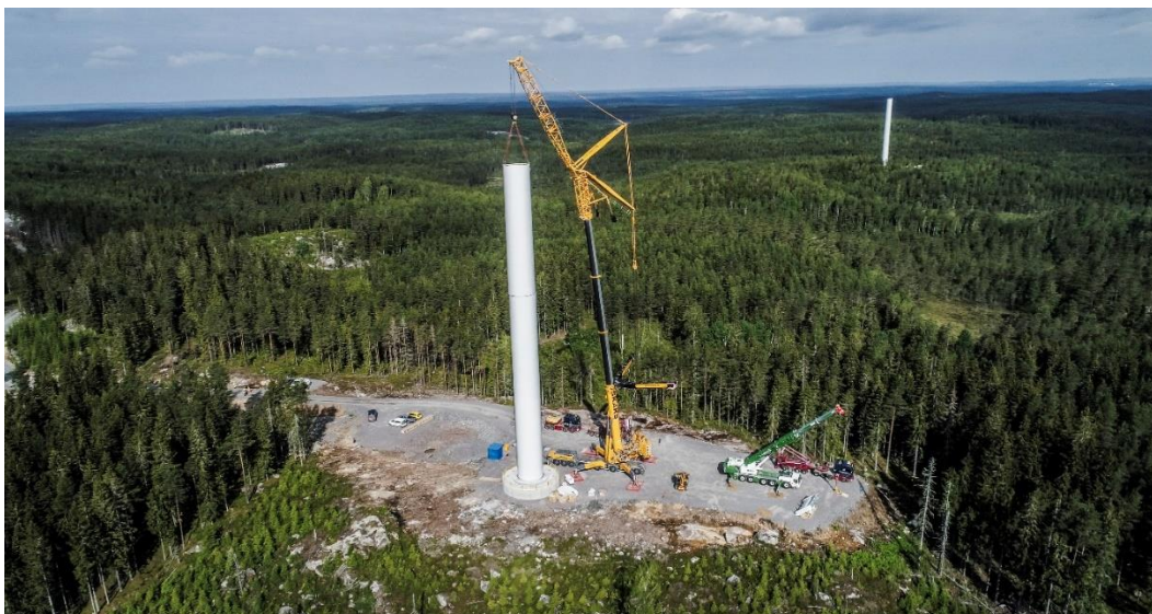
Figur 21. Montering av vindkraftverk.
