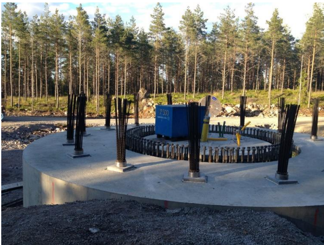
Figur 10. Bergförankrat fundament i Stena Renewables vindpark Lemnhult.
