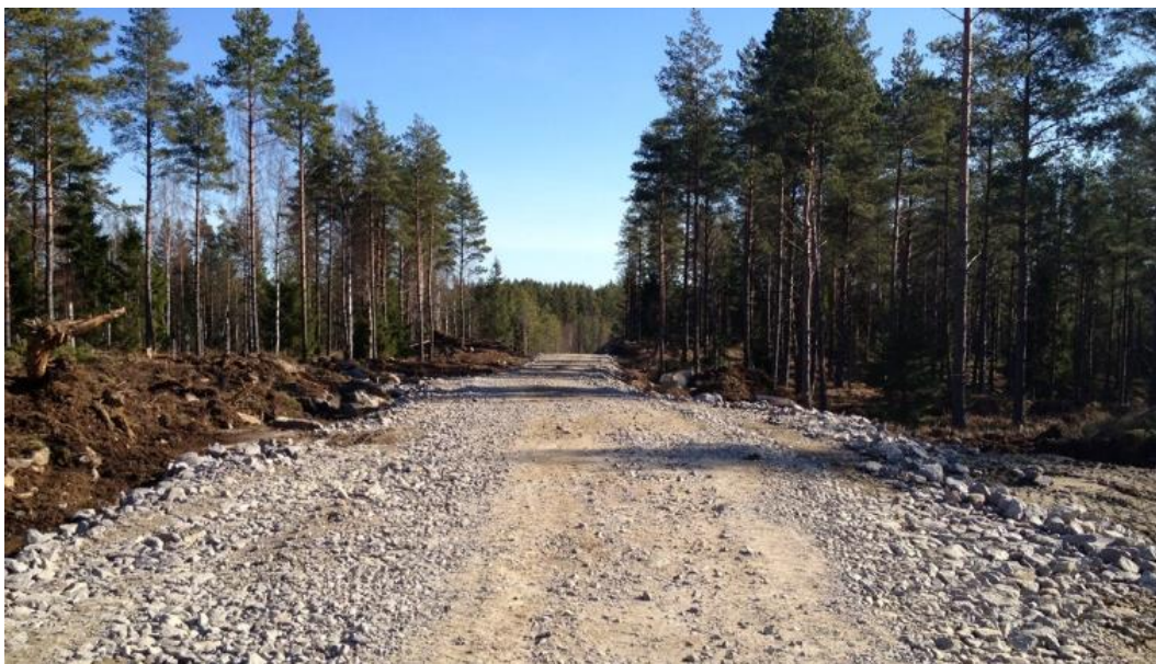
Figur 13. Ny väg under byggnation vid Stena Renewable vindpark Lemnhult, Vetlanda kommun.
