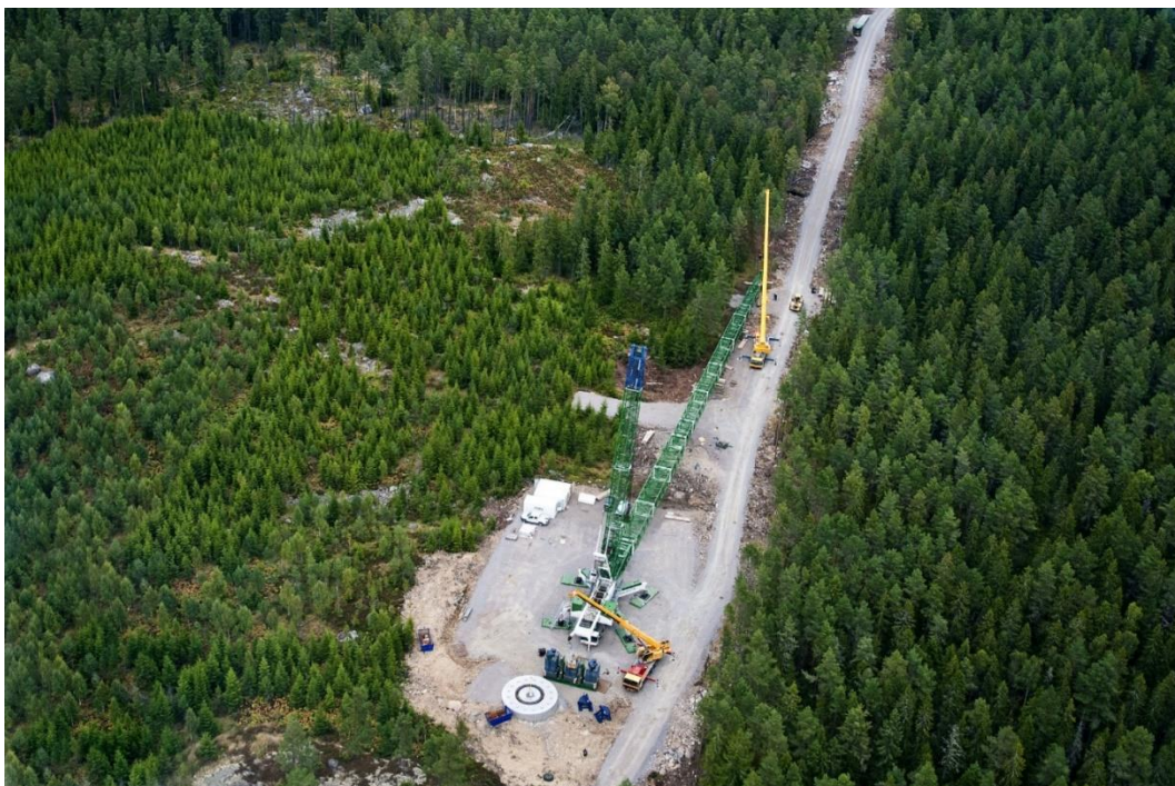
Figur 18. Flygfoto över kranyta i Vindpark Lemnhult. Källa: Stena Renewable
