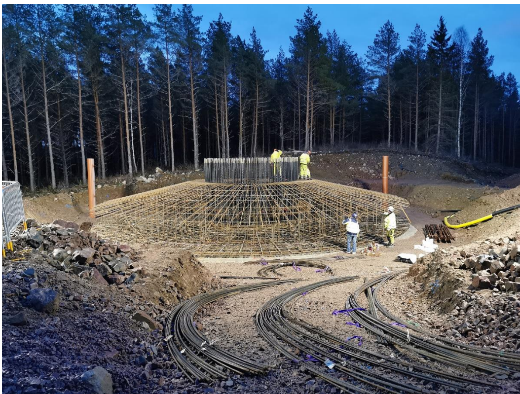
Figur 9. Gravitationsfundament i en av Stena Renewables vindparker.
