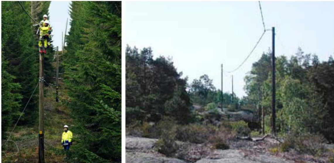
Figur 20. Exempel på utförande med hängkabel. Foto: Vattenfall.
