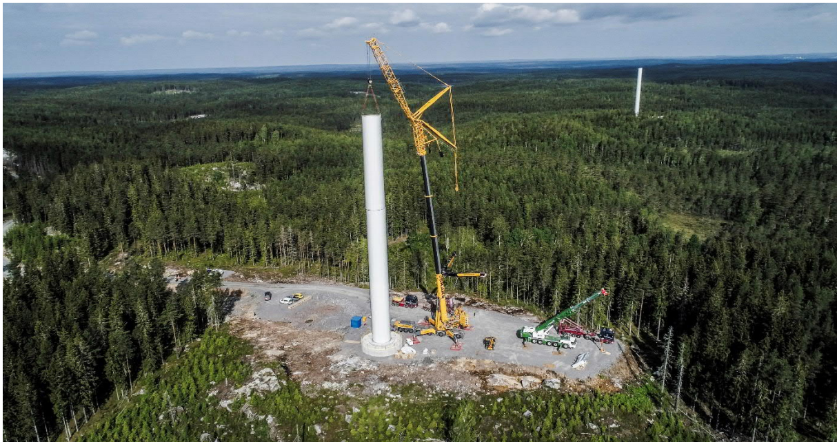
Figur 8. Montering av vindkraftverk. Foto: Stena Renewable AB
