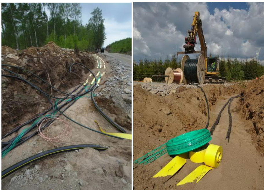
Figur 19. Kabelgrav med kabel och kommunikationsnät intill väg. Bild till vänster visar tre kabelradialer samt bild till höger tre kabelradialer. Foto: Vattenfall
