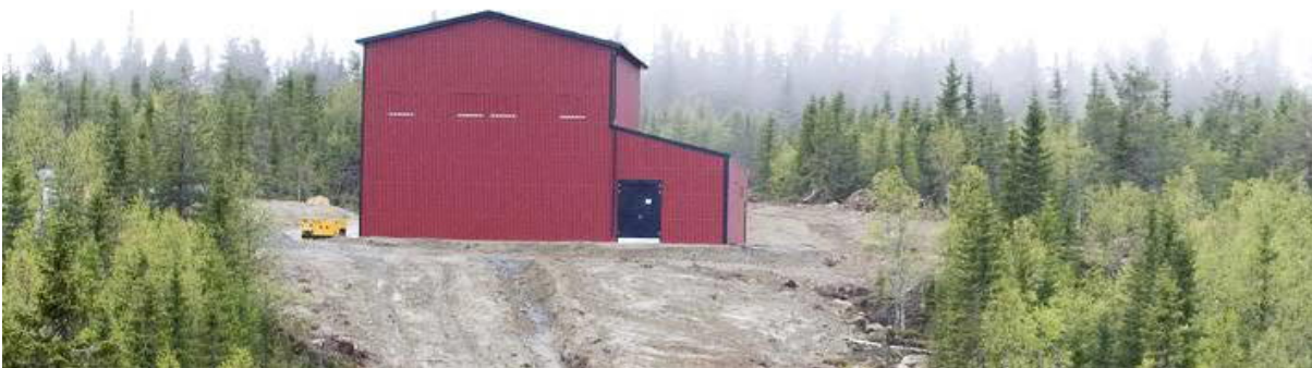
Figur 21. Foto över inomhusställverk vid Vattenfalls vindkraftsanläggning i Stor-Rottiden i Åsele kommun.
