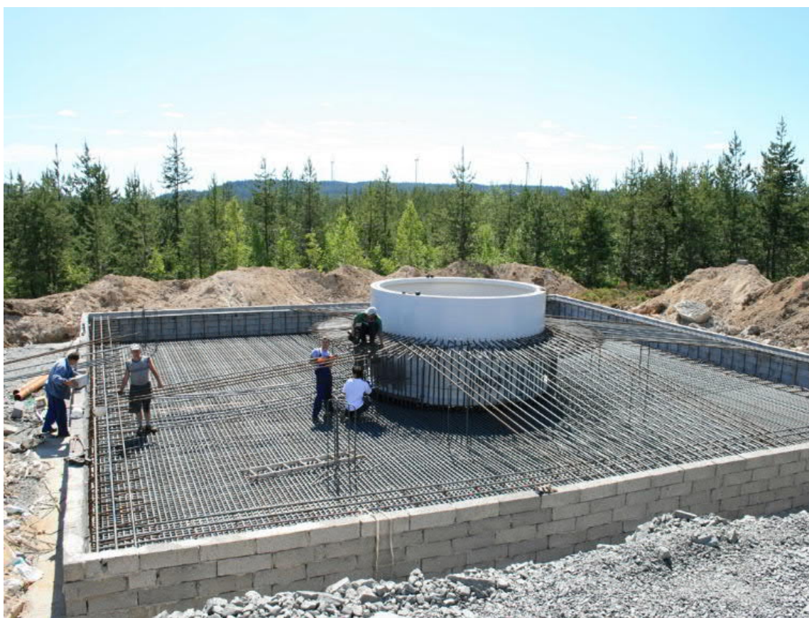
Figur 11. Gravitationsfundament i en av Stena Renewables vindparker. Källa: Stena Renewable
